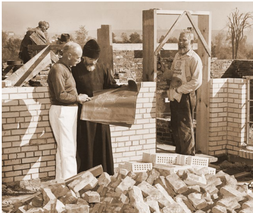
На строительствѣ храма. Октябрь 1946 г.
