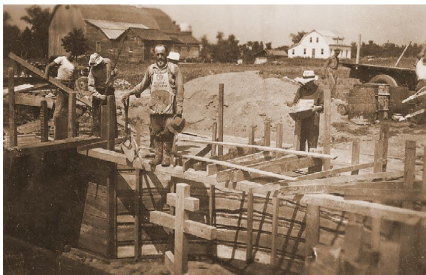
На строительствѣ храма. 10 іюля 1946 г.
